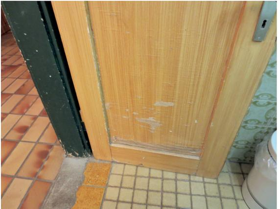
Sämtliche Zimmertüren waren durch 3 Hochwasserereignisse aufgequollen und schlossen nicht mehr richtig; diese wurden durch neue ersetzt. Im Flur wurde ein pflegeleichter Vinylboden verlegt.
